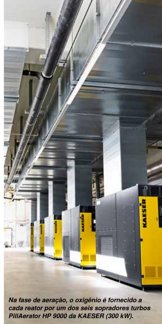
*Na fase de aeração, o oxigênio é fornecido a cada reator por um dos seis sopradores turbos Pillaerator HP 9000 da KAESER (300 kW).*
