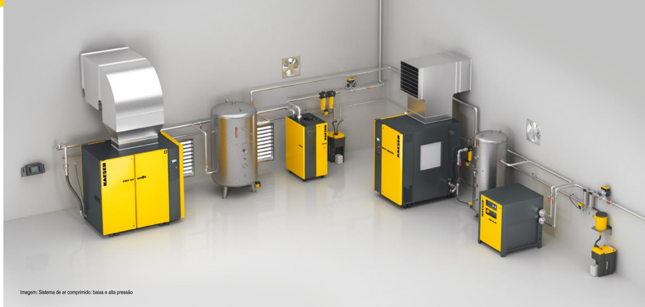
Imagem: Sistema de ar comprimido: baixa e alta pressão
